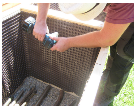
Étanchéité des bacs à plantes.
