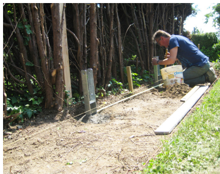
Alignement des fondations.
