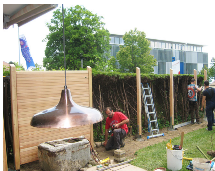
Pose des poteaux et panneaux.
